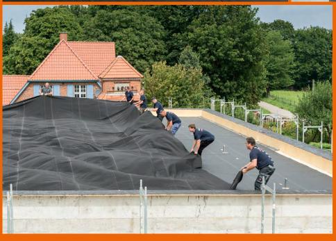
Dauerhaft dicht, dauerhaft flexibel – der vielseitige Werkstoff EPDM ist das perfekte Grundmaterial für unsere HERTALAN® Systeme.
