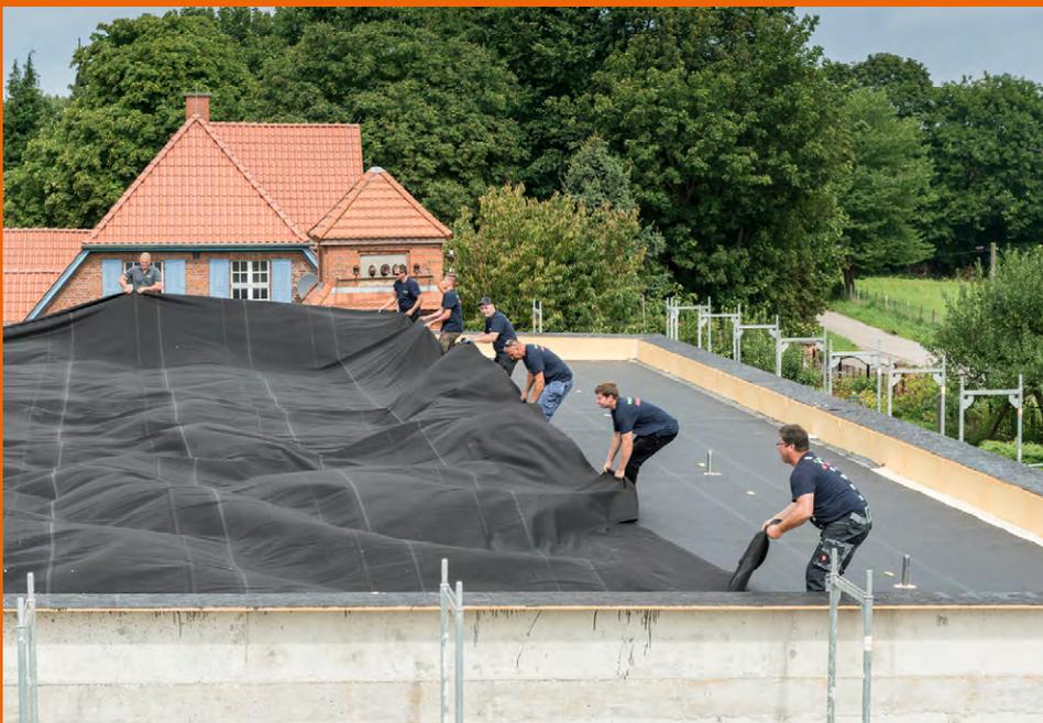
Dauerhaft dicht, dauerhaft flexibel – der vielseitige Werkstoff EPDM ist das perfekte Grundmaterial für unsere HERTALAN® Systeme. Ob als vorkonfektionierete Plane HERTALAN® EASY COVER oder als Streifen – HERTALAN® lässt sich bei Neubau oder Sanierung schnell, unkompliziert und ohne Brandgefahr verlegen.
