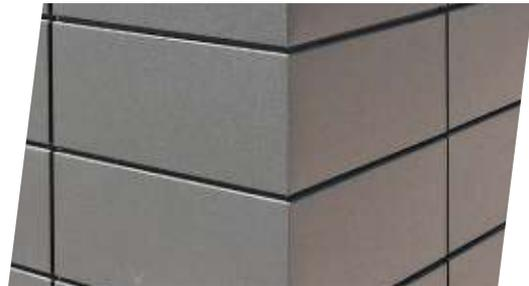
Die Verlegung der Kassetten erfolgt von oben nach unten. Dies hat den großen Vorteil, dass Beschädigungen im Zuge der Montage beinahe ausgeschlossen werden können. Auch das Bagerüst kann im Zuge der Installation von oben nach unten demontiert werden. Sollten spätere Beschädigungen an der Fassade geschehen, so sind diese meist im Bereich bis zu einer Höhe von ca. 1,5 m zu finden. Ein Austausch von beschädigten Bauteilen ist einfach zu bewerkstelligen, da die Demontage von unten beginnt.
