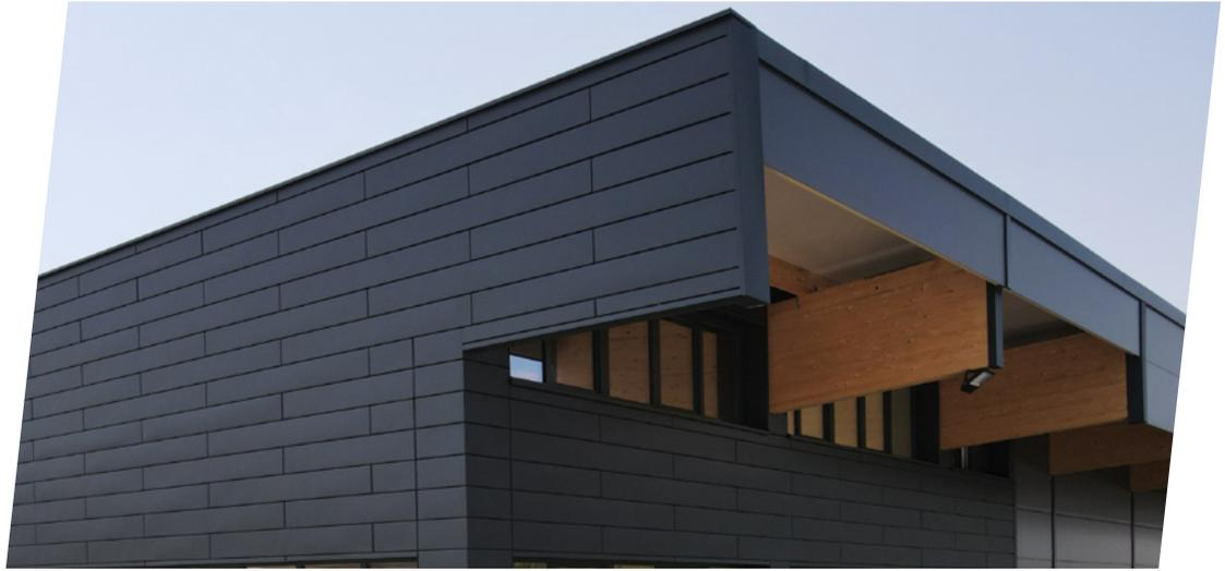
Ob im gleichmäßigen Versatz oder als wilde Deckung: durch die innovativen Fugenbleche kann jeder Querstoß frei gewählt werden. In Kombinationsmöglichkeit der 4 Kassettenhöhen zu einer Einheit können selbst ausgefallene sowie auch klassische Designansprüche verwirklicht werden.
