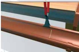
Hinteren Rinnenumbug schließen. Bei fachgerechter Klebeverbindung muss Kleber an der Innenseite austreten.
