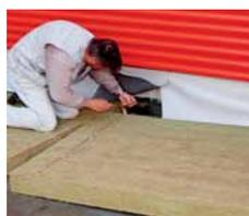
Druckbelastbare Steinwolle-Dachdämmplatte mit integrierter Zweischichtcharakteristik mit integrierter Zweischichtcharakteristik und hoch verdichteter Oberlage. Die harte Oberseite ist durch einen Schriftzug gekennzeichnet
