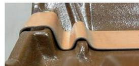
Bei Verwendung von kurzen Ausführungen bleibt die Charakteristik des verwendeten Dachziegels erhalten, ohne dass die Funktion des *heller snowstop system* beeinträchtigt wird.
