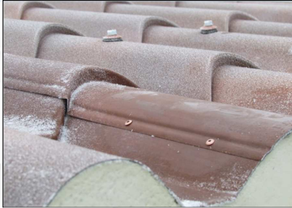
Beispiel: korrekte Installation von Verbindungsrieten
