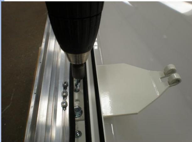
6. Gelenksbrückenfahne in die vorgesehenen Stanzungen (in der Dichtung) einschieben und verschrauben.
