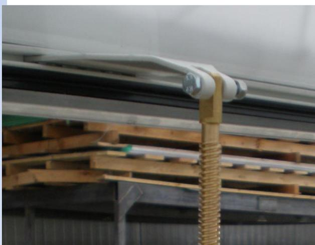
7. Spindel und Gelenksbrückenfahne mit M6x35 Schraube + Sicherungsmutter verbinden
