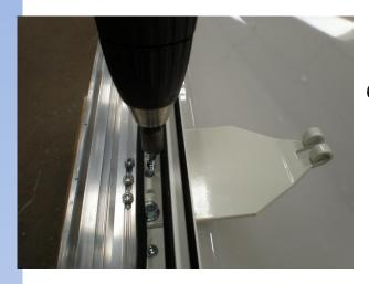
Gelenksbrückenfahne in die vorgesehenenStanzungen (in der Dichtung) einschieben und verschrauben.
